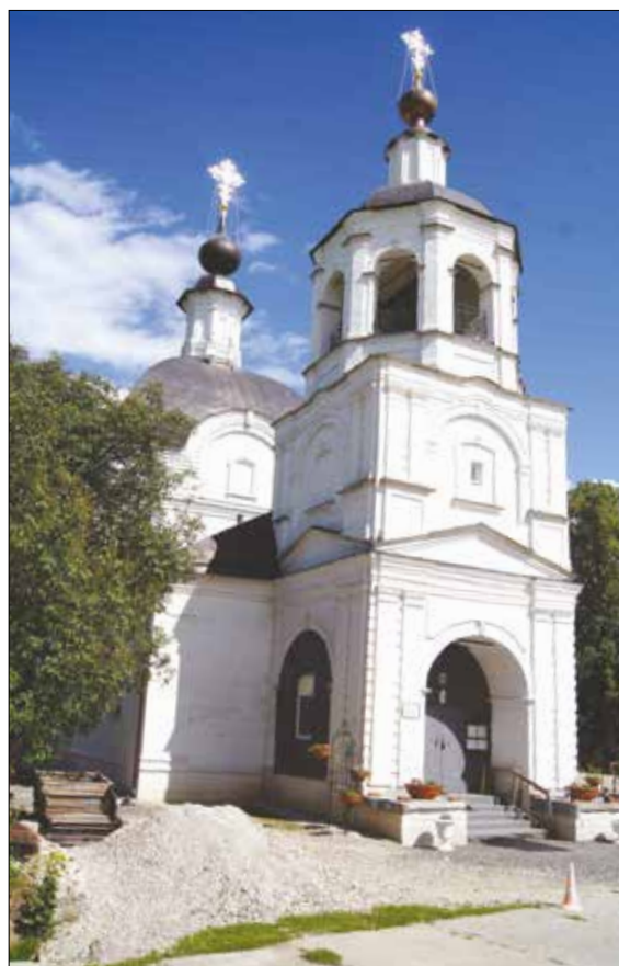
Работы по ремонту и благоустройству Храма начались много лет назад и продолжают до сих пор
